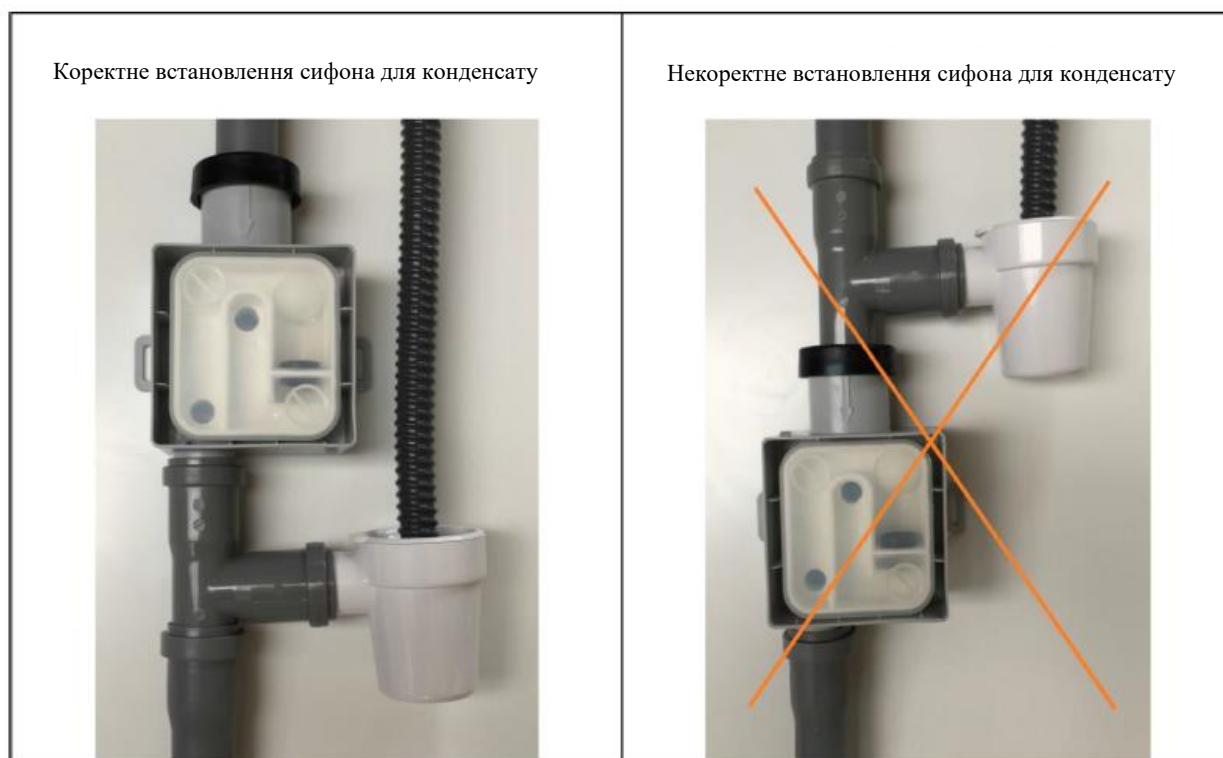
Рис. 4 – Коректне і некоректне встановлення сифона
